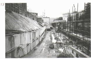
été sciée et enlevée de nuit (fig. 11) après la mise en place d'un étayage appuyé latéralement. Le reste de l'ouvrage a été démoli de jour sur le chantier.
