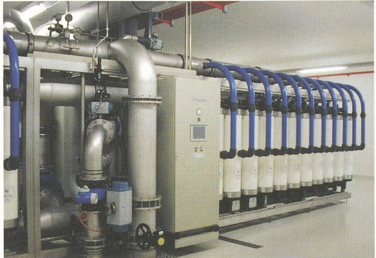
Fig. 2: Unité de production d'eau de Javel (Photo: Ville de Lausanne)
