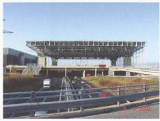
niveau d'exposition. La manutention et la pose des éléments de la structure ont été exécutées à l'aide de camions-grues sur pneus. Les poutres primaires et secondaires ont été préalablement assemblées au sol par soudage ou boulonnage, puis mises en place sur les étais par tronçon de poutres dont le poids maximum était de 87 tonnes (fig. 10 et 11).
