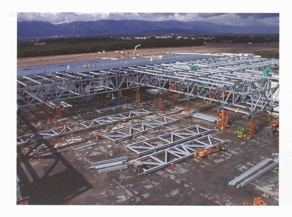
Fig. 10: Mise en place des poutres principales
