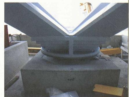
Fig. 14 : Assemblages boulonnés
