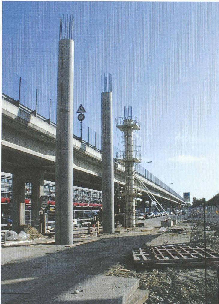
Centre de congrès. La hauteur des colonnes varie entre 6,5 m et 17 m et elles ont toutes été bétonnées en une seule volée à l'aide d'un coffrage métallique (fig. 13) avec un béton de type B45/35. Pour éviter les problèmes de ségrégation, un bétonnage au tube plongeur a été requis.
