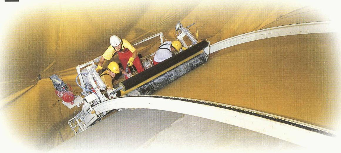
Entre Payerne et Yverdon se construit actuellement le dernier tronçon de la route nationale A1. Lors des travaux d'étanchéité réalisés sur cet ouvrage de 540 m de long de la «Tranchée couverte de Sévaz», percé sous la ligne ferroviaire, l'entreprise SikaBau Zurich et son partenaire\* ont dû maîtriser deux problèmes:
