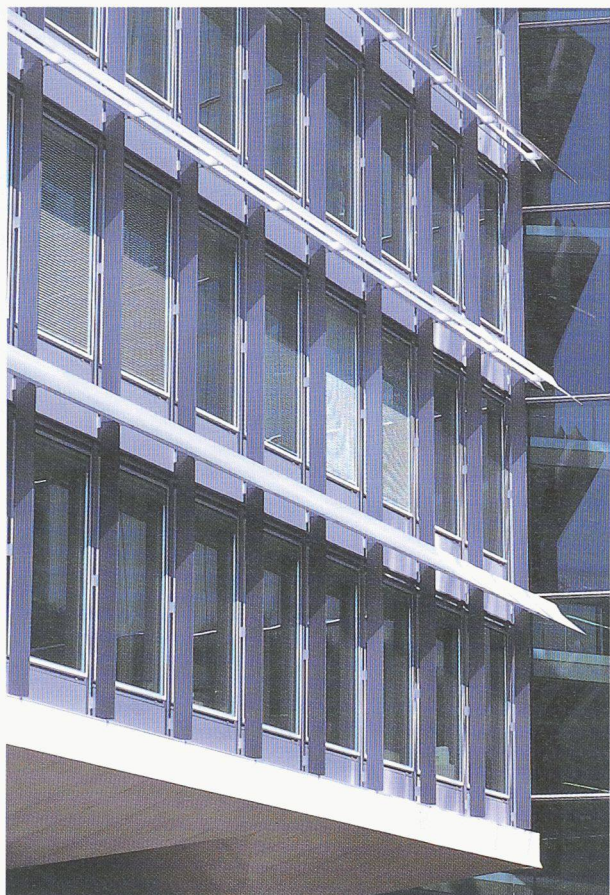
Fig. 6. Façade sud après rénovation (Photo Pierre Boss, Renens)
