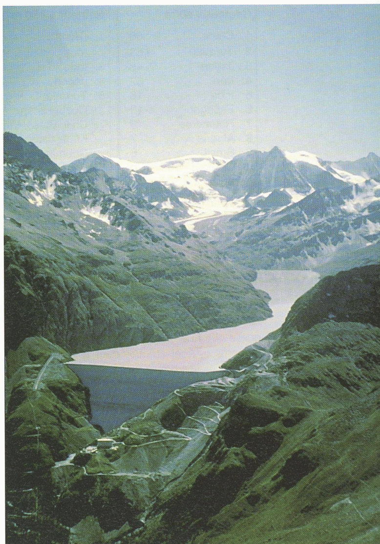
Fig. 5. – Barrage de la Grande-Dixence (285 m)
