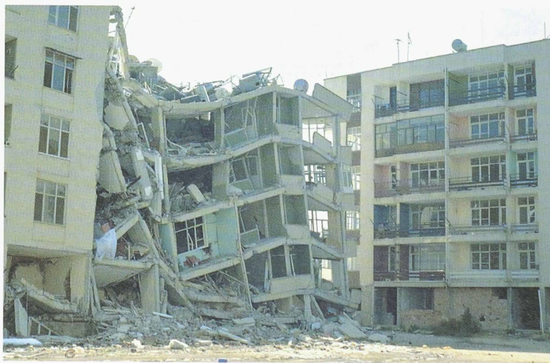
Fig. 4. – Deux immeubles d'habitation avec des structures porteuses semblables montrent un comportement totalement différent : l'immeuble de gauche est détruit (niveau de dégâts 5) tandis que l'immeuble de droite pourra être réparé (niveau de dégâts 3)
