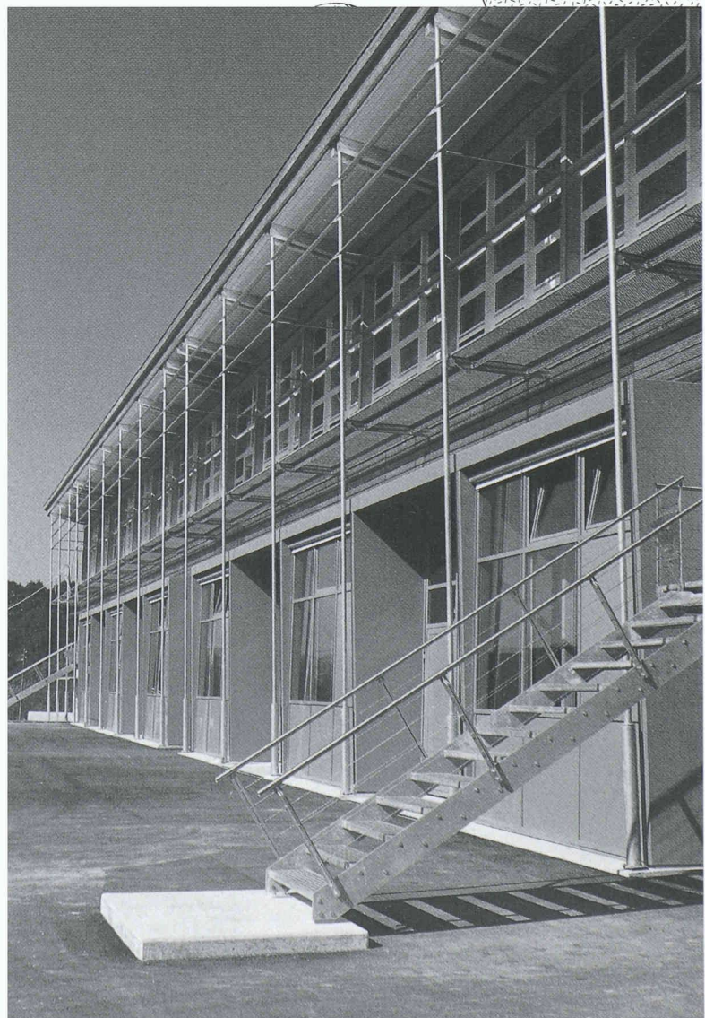
Vue de la façade sud
