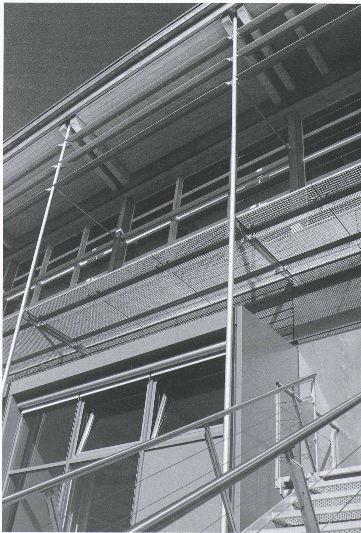
Vue de la coursive sur la façade sud
