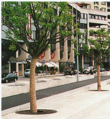
Les grilles d'arbres en fonte "BUDERUS", quai du Seujet à Genève,
