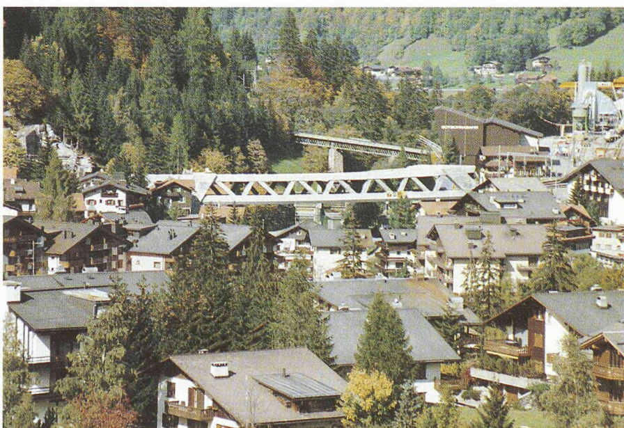
Fig. 6 et 7. – Deuxième pont sur la Landquart à Klosters, construit en béton armé par R. Maillart; à l'arrière-plan, on distingue l'ancien pont renforcé
