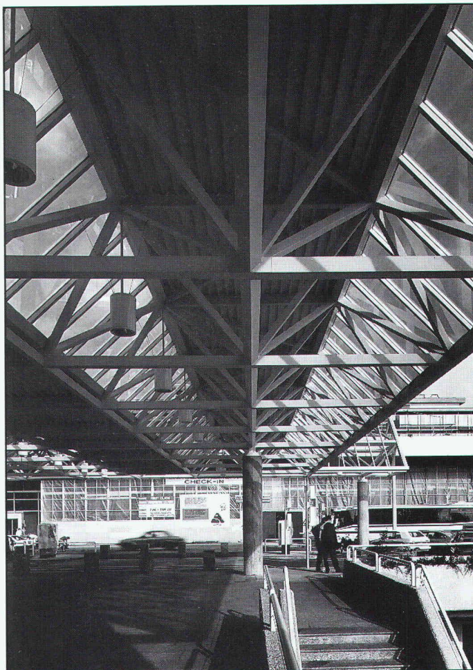
Poutres triangulaires en RHS au-dessus de la station d'autobus à l'aéroport de Genève-Cointrin.
