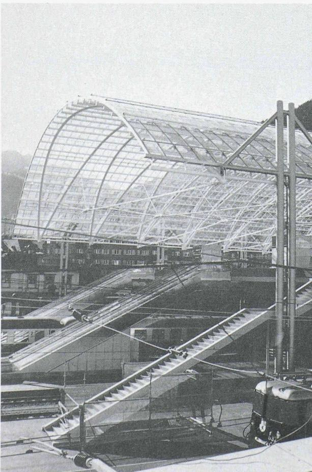
duction avec, en plus, des tolérances minimales dans les dimensions. Le raccordement, par soudure, des pannes aux arcs présente une géométrie variable selon la hauteur de celles-ci et a nécessité le recours à un robot spécialement programmé.
