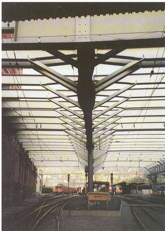
Poutraison métallique de la dalle mixte
