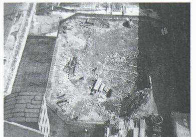
Fig. 9. – Bétonnage de l'anneau de compression, 2<sup>ème</sup> étape, août 1991
