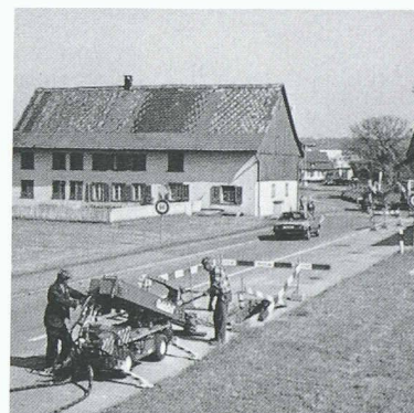
L'affût de forage et la fouille d'attaque dont on remarquera la taille réduite
