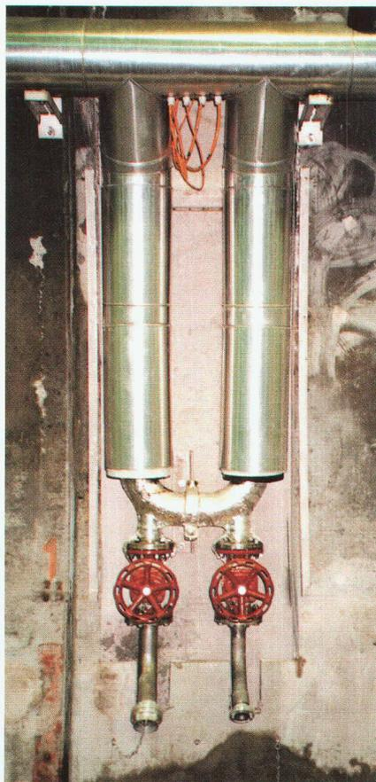
**V**ue de détail d'un poste d'extinction dans sa construction brute. On voit distinctement les conduites d'alimentation déjà isolées ainsi que les deux vannes revêtues électrostatiquement à l'intérieur et à l'extérieur de résine époxyde (EKB), GGG-40, de SCHILLING.
