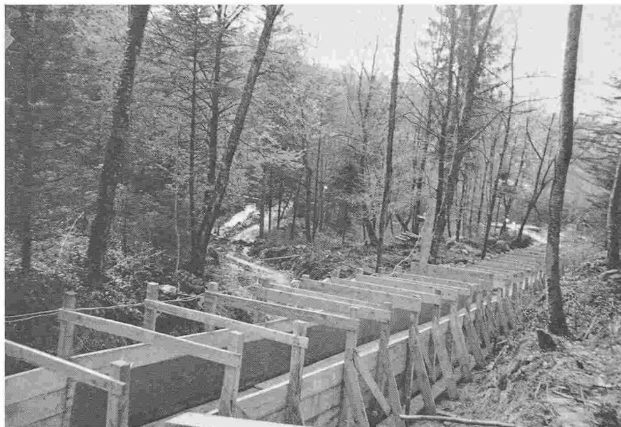
Fig. 3. - Mesure d'urgence, le chenal provisoire.
