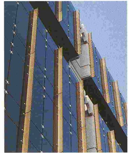
Au 4 e étage, la peau de la façade présente un renforcement contribuant au sentiment d'harmonie dégagé par la façade.
