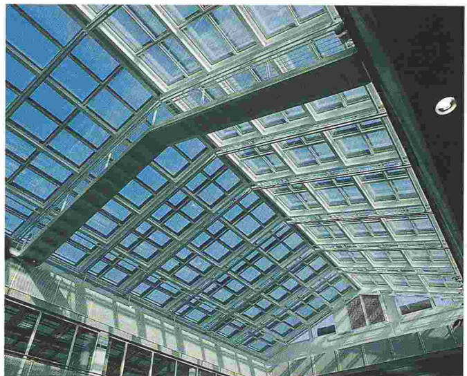
L'ensemble du vitrage peut être ouvert pour l'entretien. La conception analogue à celle de la façade froide a permis d'améliorer considérablement l'amortissement phonique.
