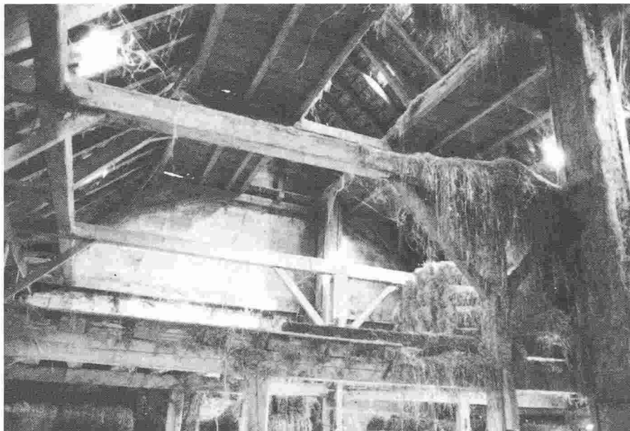
La grange du Spittelhof, à Zofingue, avant rénovation.
