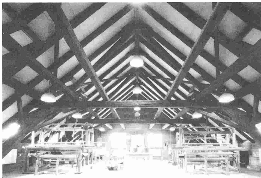
Ferme et grange transformées par l'architecte Werner Schmutz en un centre de loisirs du Spittelhof. Le système de sous-couverture SarnaRoof, grâce auquel les activités de loisirs peuvent se dérouler dans un climat ambiant agréable, a été réalisé sur la structure porteuse, qui est ainsi restée apparente.
