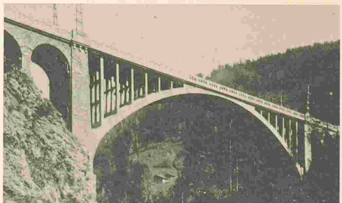
Le pont des Planches: un monument historique du patrimoine technique vaudois.
