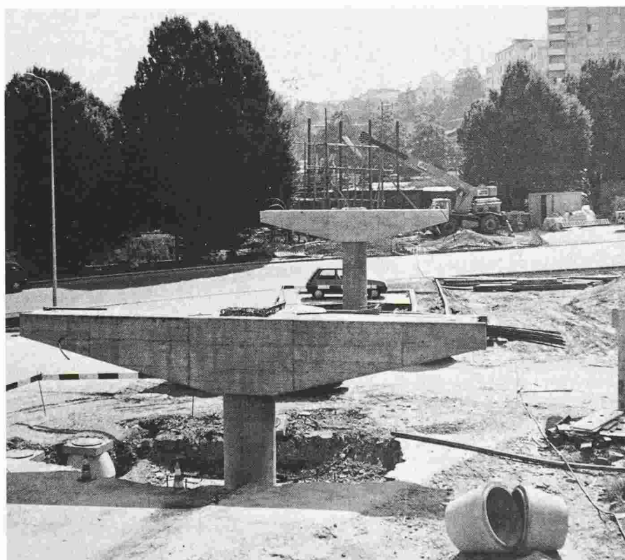
Fig. 3. - Viaduc de Sévelin: piles décoffrées.
