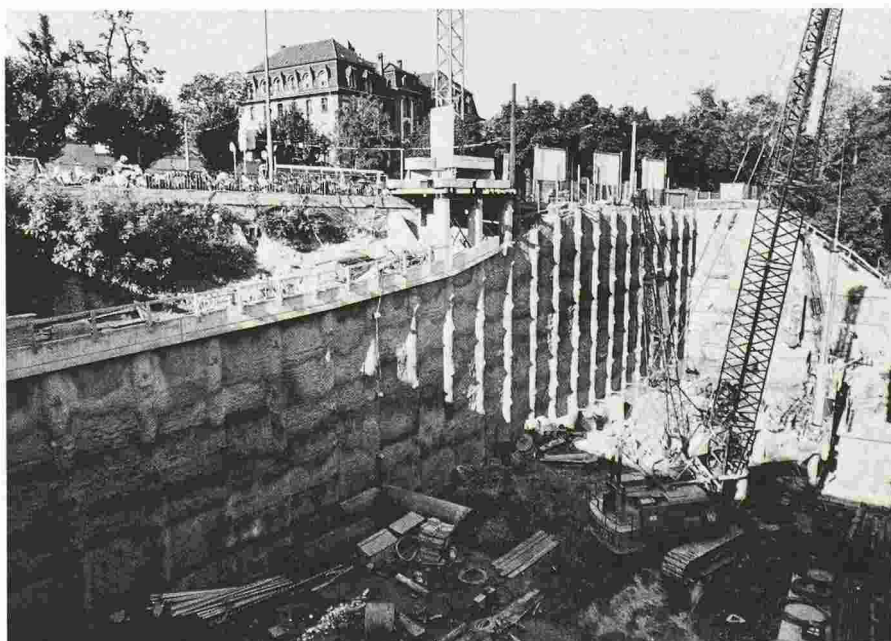
Fig. 5. - Station de Lausanne-Flon : paroi berlinoise et paroi épinglée ouest.
