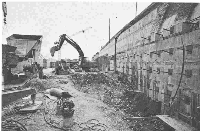
Sur 200 m, l'autoroute accolée à la falaise est bordée d'un long mur ancré profondément dans la roche, et dont l'épaisseur totale atteint par endroits 2 m. La place limitée à cet endroit, l'ampleur de l'ouvrage à réaliser et la densité du trafic qui continue de se dérouler derrière les palissades font de ce chantier un modèle d'efficacité.
