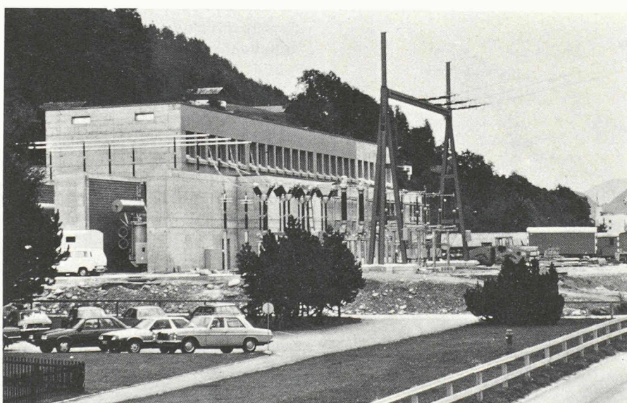
Usine d'Ilanz abritant les groupes des aménagements I + II:
