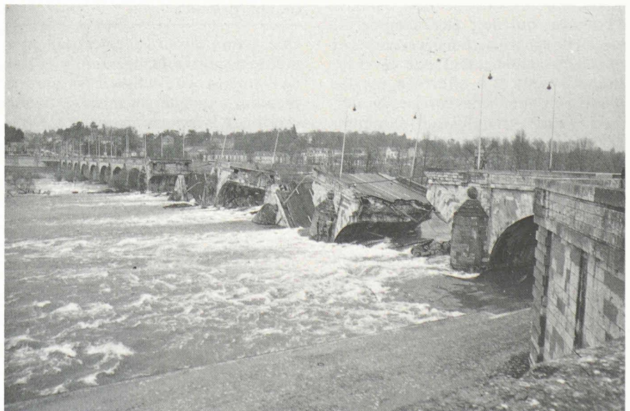
Fig. 17. – Effondrement du pont Wilson, sur la Loire, à Tours, le 9 avril 1978 : le niveau du fond du lit du fleuve s'est progressivement abaissé, notamment à la suite des extractions de sable effectuées en aval (même très loin).
