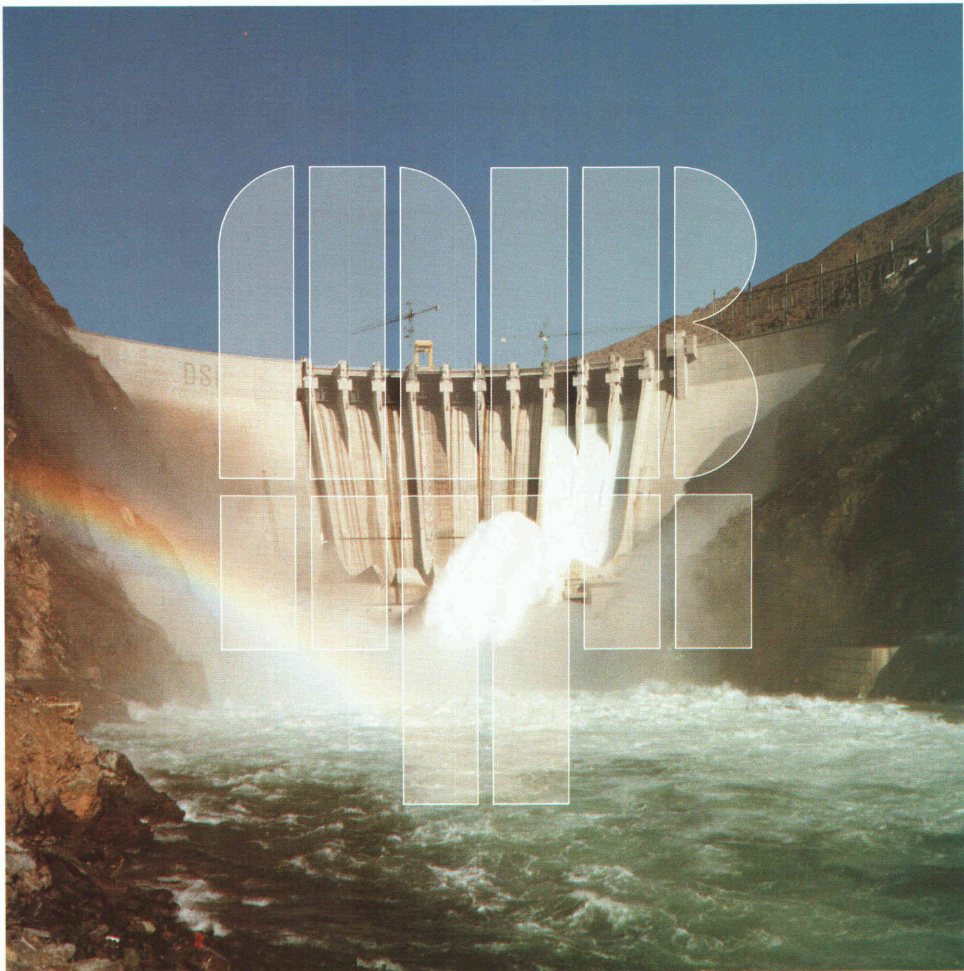
Barrage de Karakaya en Turquie: 630000 m 3 de béton au superfluidifiant Rheobuild.
