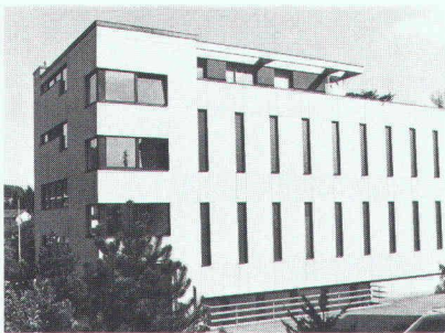
Bâtiment des télécommunications à Unterengstringen
