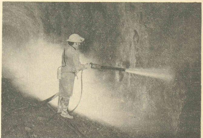
Application de béton projeté dans un tunnel.
