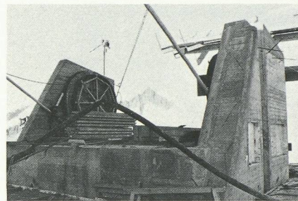
Fig. 2. - Le massif d'ancrage des câbles porteurs du téléphérique avant sa couverture.
