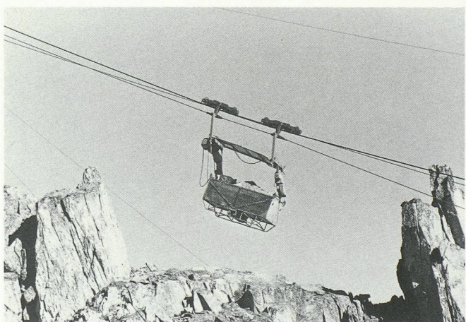
Fig. 6. - Le téléphérique de chantier (charge utile 3,0 t) a été démonté à la fin des travaux.
