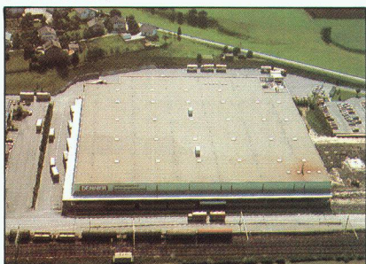
▲ Suisse : Centre de distribution Denner, Schmiten.
