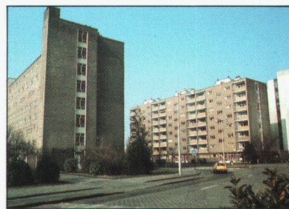
▲ Belgique : Immeuble d'appartements sociaux, Gand. (rénovation)
