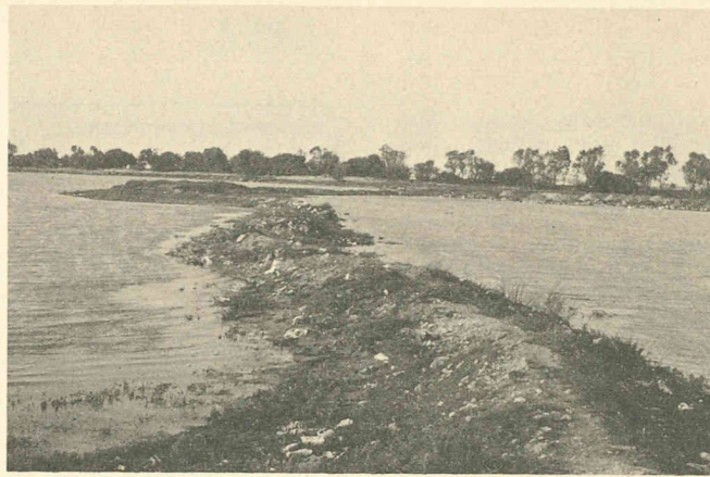
Lac d'eaux pluviales.
