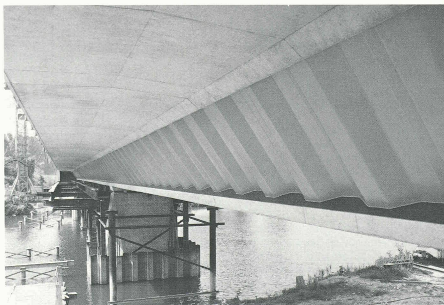
Fig. 9. — Pont de Cognac.
