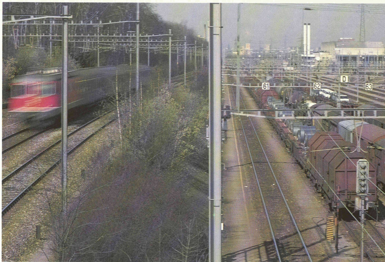
Le transit de marchandises nord-sud a longtemps été une source majeure de revenus pour les CFF et le BLS. Il vaut donc la peine de tout mettre en œuvre pour offrir dans ce domaine des conditions concurrentielles. A la gare de triage de Muttenz (Bâle, photo) doivent correspondre les voies d'accès aux tunnels alpins, tant au nord qu'au sud. Sur ce dernier versant, une bonne collaboration avec les chemins de fer italiens est une condition essentielle.
