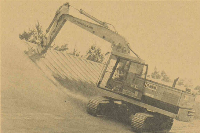
Pour planer 30 000 m 2 sur la piste d'essai Volkswagen en l'espace de 4 semaines, l'entrepreneur a monté des planeuses FF-Blitz Eurobauma sur trois pelles hydrauliques 215 Cat.
