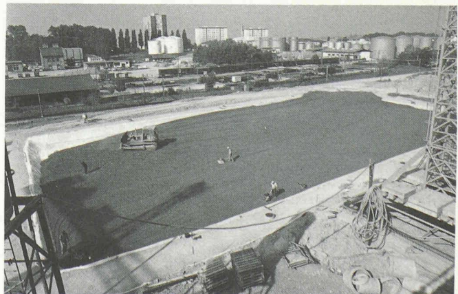
Fig. 12. — Vue générale d'une piste extérieure: répartition du LECA.
