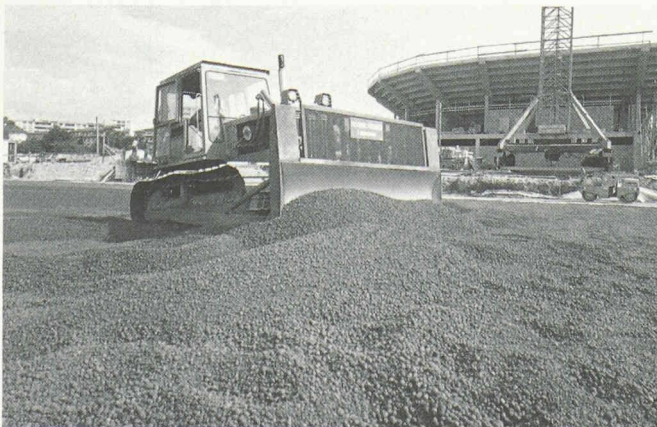
Fig. 11. — Mise en place du LECA.
