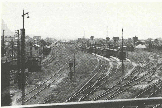
Une partie de la gare d'Annemasse en été 1949. (Photo C. Weltli.)
