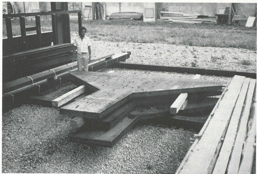
Fig. 8. — Les «tulipes» avant usinage.
