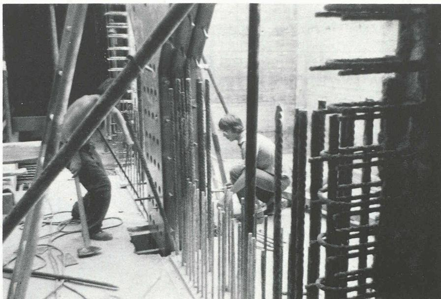
Fig. 10. — Boulonnage des tiges filetées.
