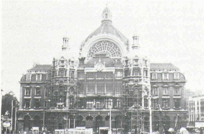
Fig. 1. — L'imposante Gare centrale d'Anvers et le matériel de l'entreprise sur le chantier des travaux souterrains.
