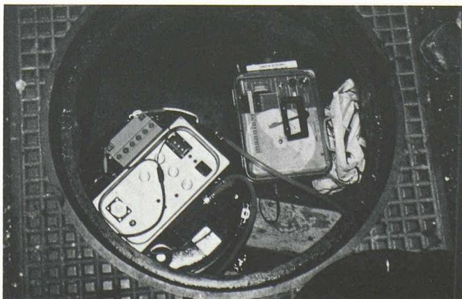
Fig. 2. — Débitmètre et préleveur automatique installés.
