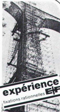
Fixation d'un coffrage
