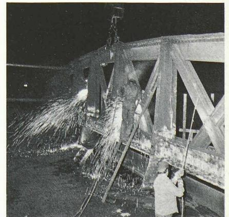
Fig. 2. — Démolition de l'ancienne structure à l'aide de grue-rails 25 t du type « Vevey », par l'équipe des ponts du 2<sup>e</sup> arrondissement CFF.
