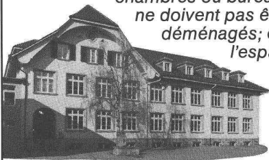
Ecole à Bremgarten, BE. Rénovation avec fenêtres à cadre rapporté bois et vitrage isolant.
