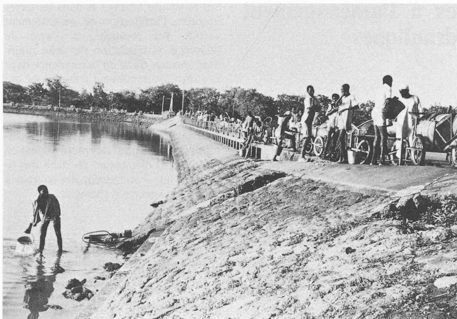
Fig. 1. — L'impact global d'un barrage ou d'une retenue d'eau n'est pas toujours facile à prévoir. Une approche pluridisciplinaire permet souvent d'éviter ou, tout au moins, d'atténuer les conséquences défavorables de l'ouvrage.
