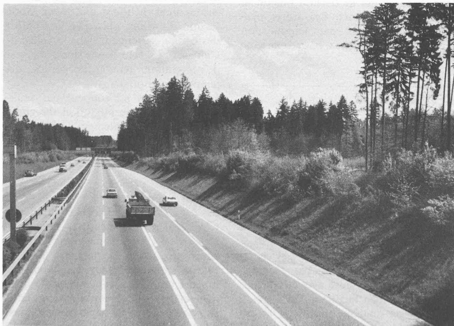
Si l'on ouvre une tranchée dans un peuplement fermé, le risque de renversement par le vent est élevé. Avec le temps, les dégâts progressent constamment dans les forêts adjacentes.
