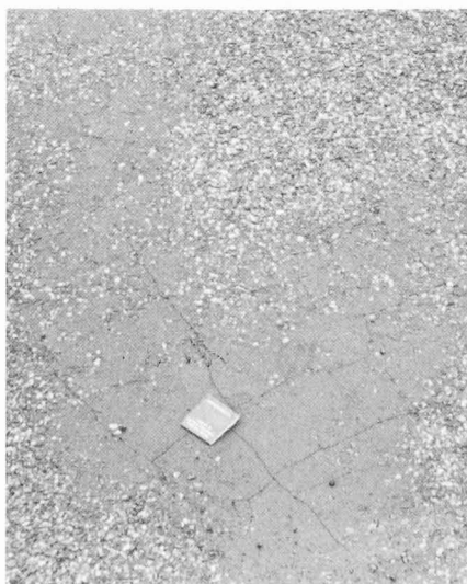
Fig. 6. — Ce revêtement d'asphalte coulé s'est désagrégé après un hiver seulement, l'étanchéité étant épaisse et trop tendre.
