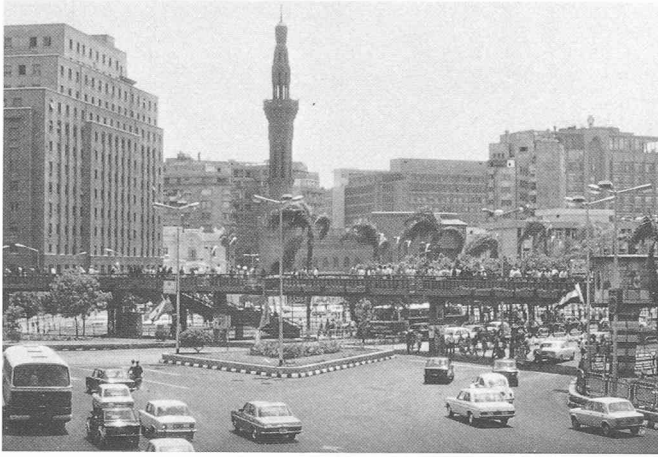
Vues de la place El Tahrir au centre du Caire, Egypte. Un giratoire piétonnier complet érigé en estacade assure les liaisons entre les quartiers adjacents.
