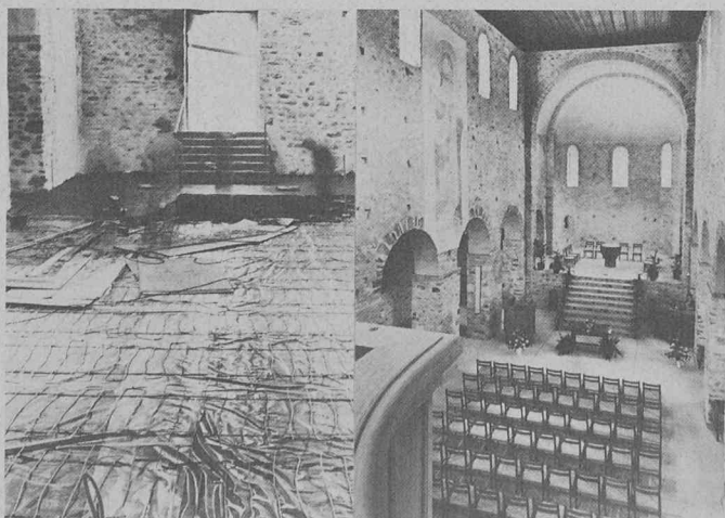
L'église d'Amsoldingen est chauffée de manière invisible. Dans l'église médiévale restaurée d'Amsoldingen, un système de chauffage moderne fournit chaleur et bien-être sans radiateurs ou conduits d'air encombrants. L'installation d'un chauffage électrique par le sol, de Câbles Cortailod SA, a permis de préserver le caractère historique du monument, tout en tenant compte des exigences de confort de notre époque. Le chauffage par le sol Pyrotex constitue une véritable alternative aux systèmes de chauffage traditionnels.
