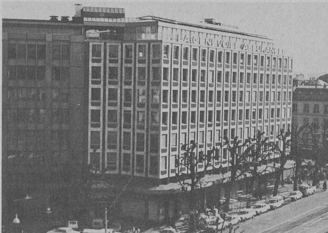
L'immeuble de la Genevoise Assurances, au carrefour de Rive, à Genève. Des capteurs solaires sur le toit et une installation de récupération de chaleur assurent un bilan énergétique particulièrement favorable à cette construction.
