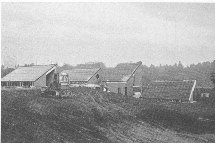
Fig. 1. — Vue d'ensemble de l'installation.
