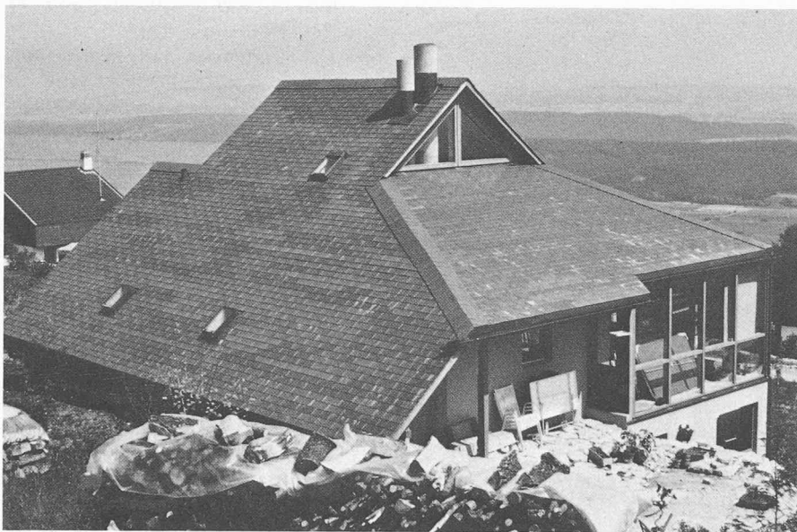
Fig. 3 — Façades ouest et nord.
