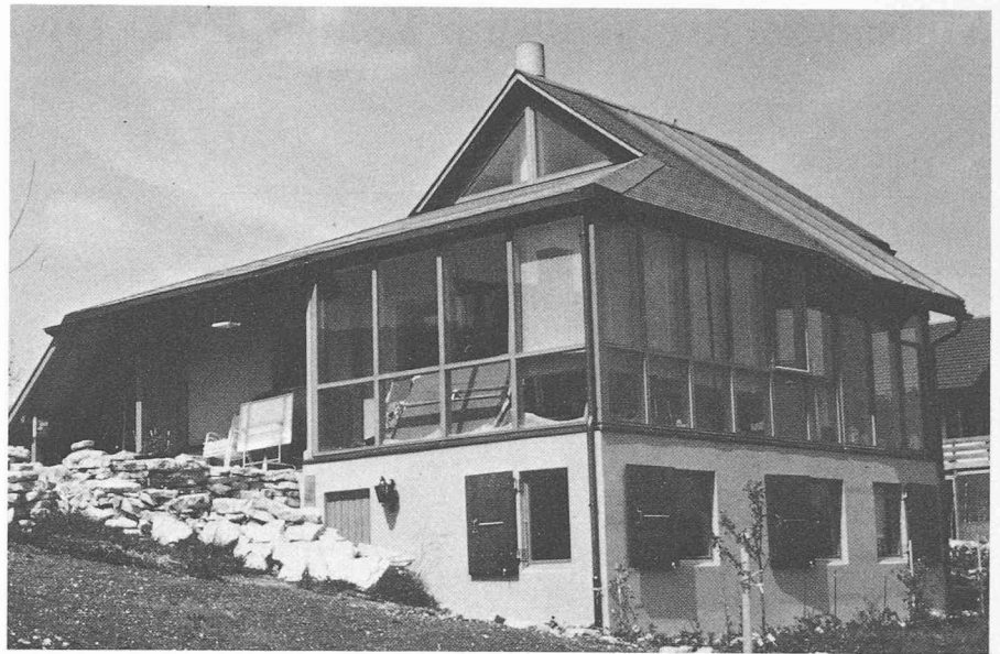
Fig. 2 — Façades sud et ouest.
